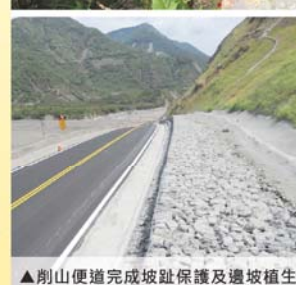
▲削山便道完成坡趾保護及邊坡植生
