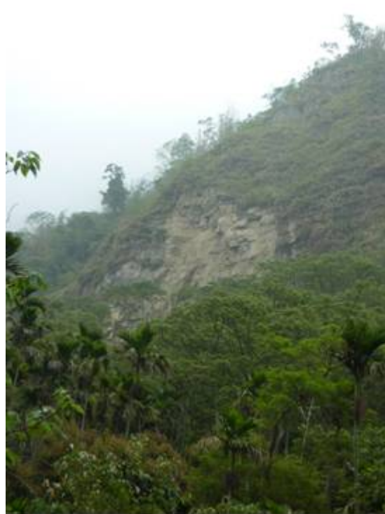
上方邊坡為順向坡有自由端出露
