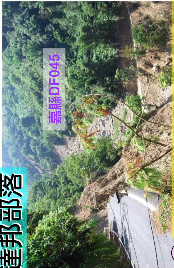
2 下邊坡169縣道圓弧型破壞、路基流失
